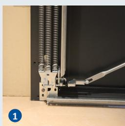
Verrouillage mécanique avec 2 loqueteaux réglables en partie basse du panneau.
