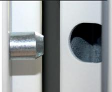
Huisserie d'angle en profilé d'acier galvanisé d'épaisseur 15/10<sup>ème</sup> mm.
